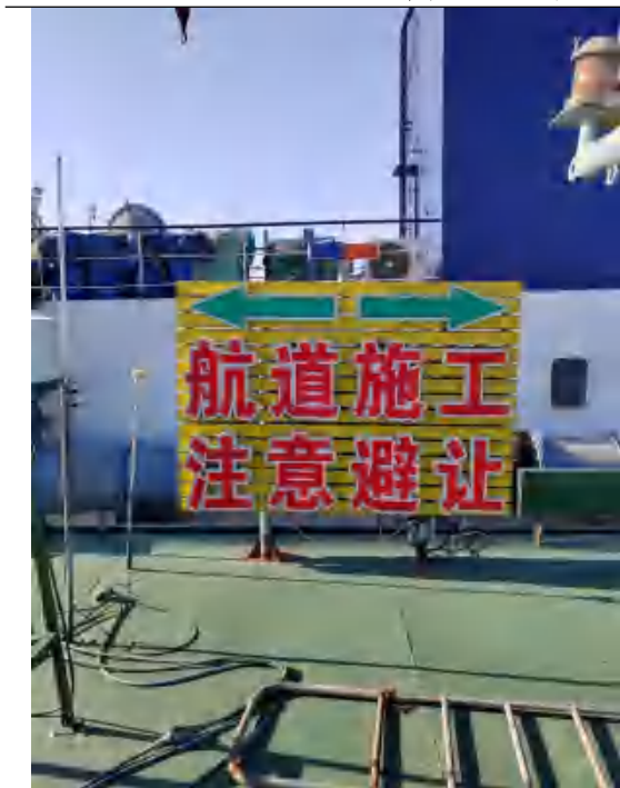
图 4.1-31 航道施工警示灯
