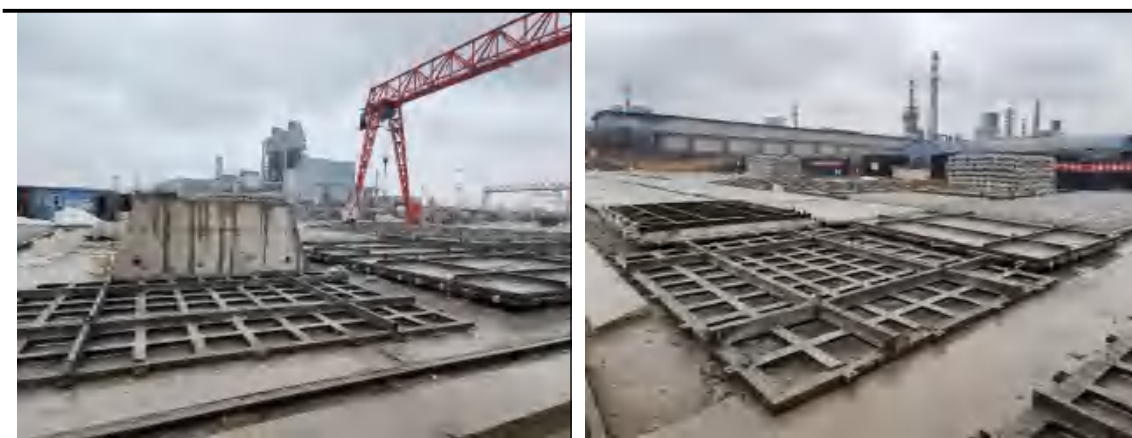
图 2.2-1 灌南县预制件施工场
