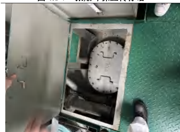
图 4.1-9 施工船舶储油柜
