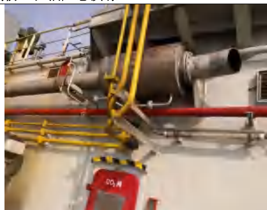
图 4.1-34 排气管消音器
