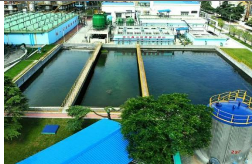
炼油厂区污水处理系统
