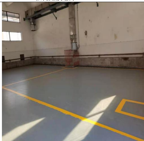
防腐防渗地坪
