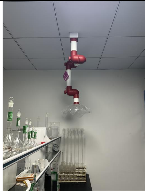
实验废气收集措施
