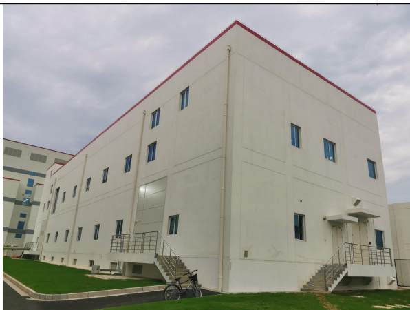
110KV 变电站主视图
