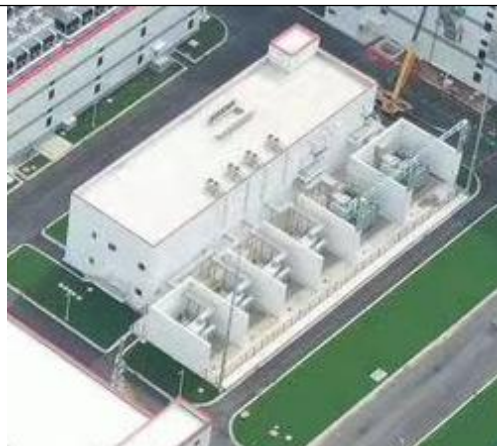
110KV 变电站鸟瞰图
