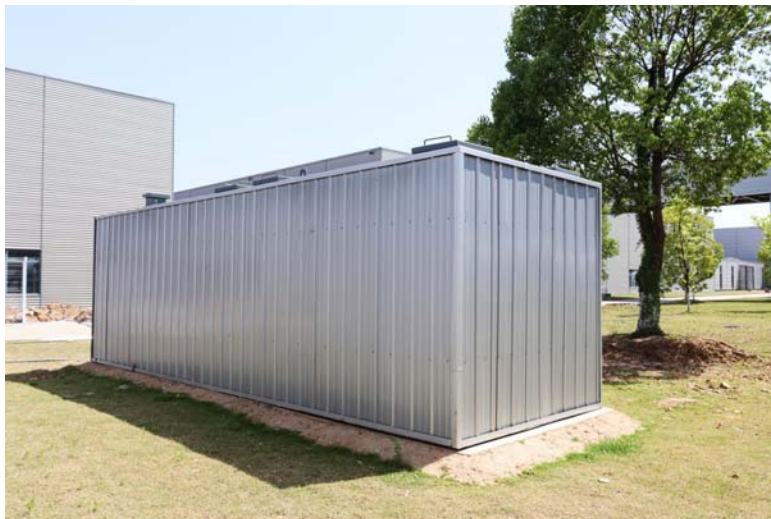
图 3-2 污水处理设施照片
