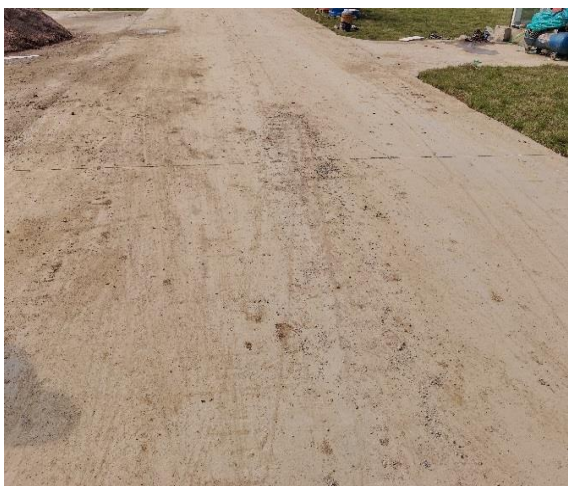
图 6-1 施工现场道路硬化
