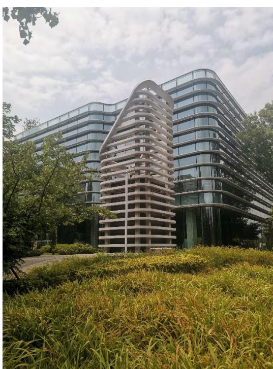
图 4.1-3 地下停车场通风排气口
