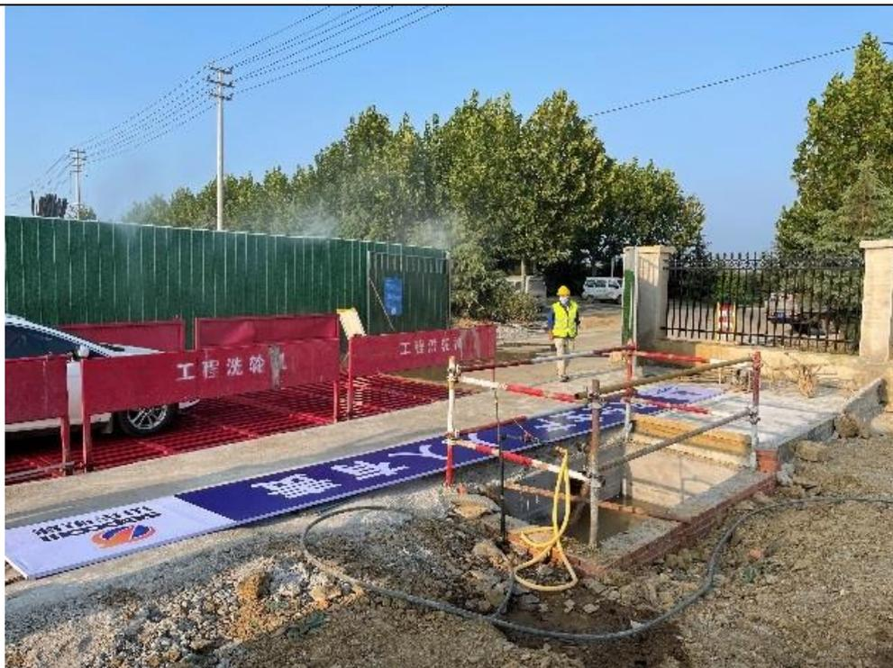
图 6-1 施工现围挡、降尘、洗车措施
