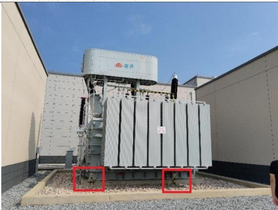
图 6-3 主变高压接地装置
