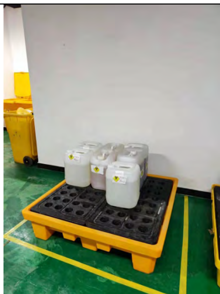
3楼危废库内防滲托盘
